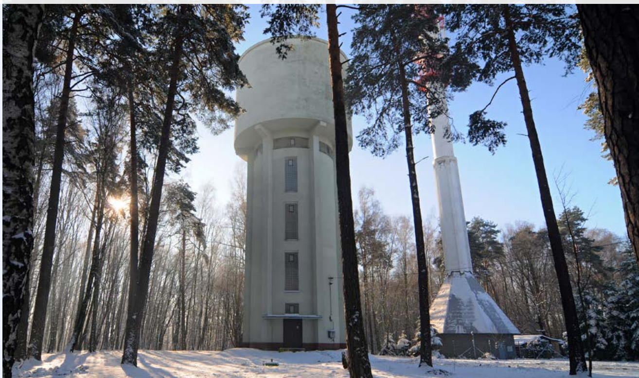
Věžový vodojem v Petřvaldu na Karvinsku.
