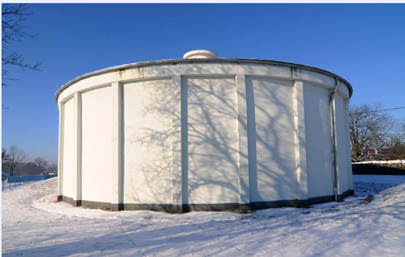
Vodojem v části Orlové Výhoda. Řada akumulací na Karvinsku byla vybudována tak, aby lépe odolávaly následkům hornické činnosti v regionu.
